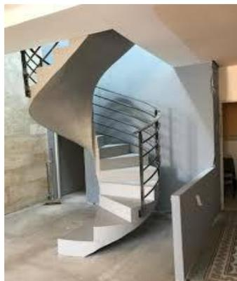
**Figure 6.10**–Escalier hélicoïdal en béton armé [28]
