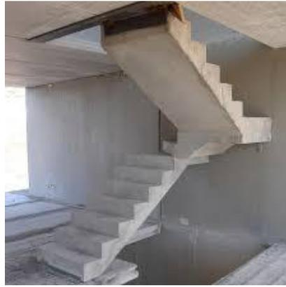
**Figure 6.8**–Escalier droit en béton armé [26]
