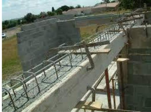
Figure 3.7– Poutre en béton armé [21]
