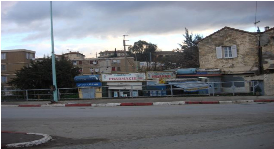
Figure 3 ; Vue piétonne sur les locaux commerciaux avant la démolition
